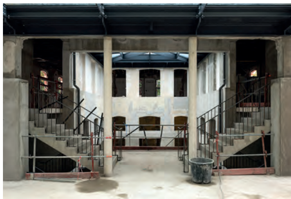
6. Vue intérieure sur le futur atrium du musée © Pierre Antoine
